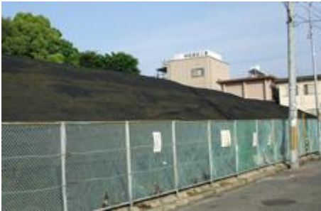
平成24年 18年経過後の施行現場
