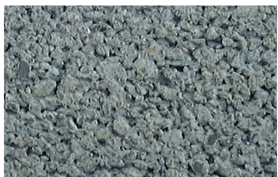
写真④ ドライウェイ(無機バインダー使用) (施工後3年程度) カラータイプ: ポルトランドグレー
